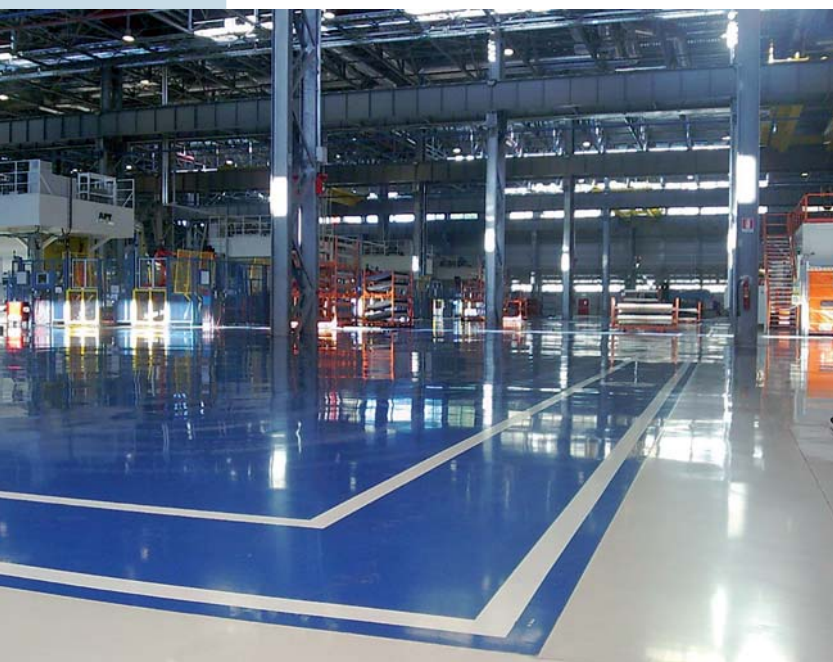
FIG 01 | Visione dall'ingresso del reparto dello stabilimento Fiat di Cassino dedicato allo stampaggio a caldo; sulla sinistra una della linea di presse meccaniche per la rifilatura e foratura dei componenti stampati.
