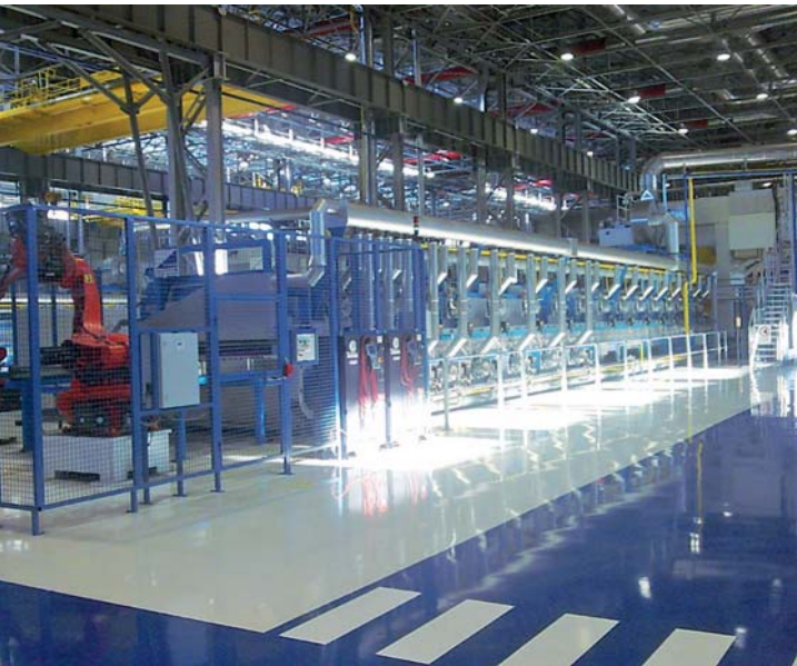
FIG|02 Una delle 5 linee di forni di riscaldamento delle lamiere con, sulla parte destra, la pressa di formatura a caldo dei componenti precedentemente tranciati.
